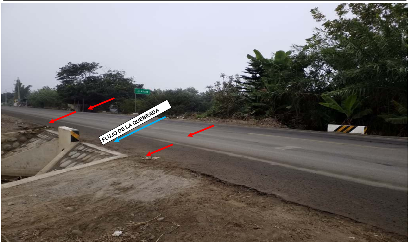
FIGURA N°03: EN LA TEMPORADA DE MAXIMAS AVENIDAS LA QUEBRADA HUAREQUEQUE SE DESBORDA, POR LA MARGEN DECHECHA E IZQUIERDA, EN EL SECTOR HUAYAN, DISTRITO DE HUARAL, CUYO TRAMO SE ENCUENTRA COLMATADO Y DESPROTEGIDO, VULNERABLE A LAS VELOCIDADES EROSIVAS DEL RÍO. EN EL TRAMO FINAL LA QUEBRADA HUAREQUEQUE CRUZA LA CARRETERA PARA TRATAR DE DESEMBOCAR AL RIO CHANCAY-HUARAL.
